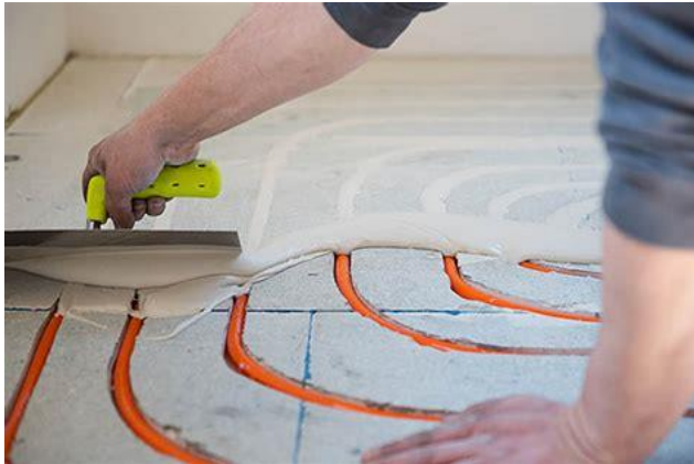
Vloerverwarming ingefreesd in cementvezelplaten
