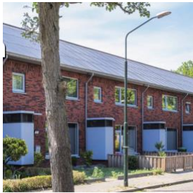
Kasten met installaties aan de voordeur
